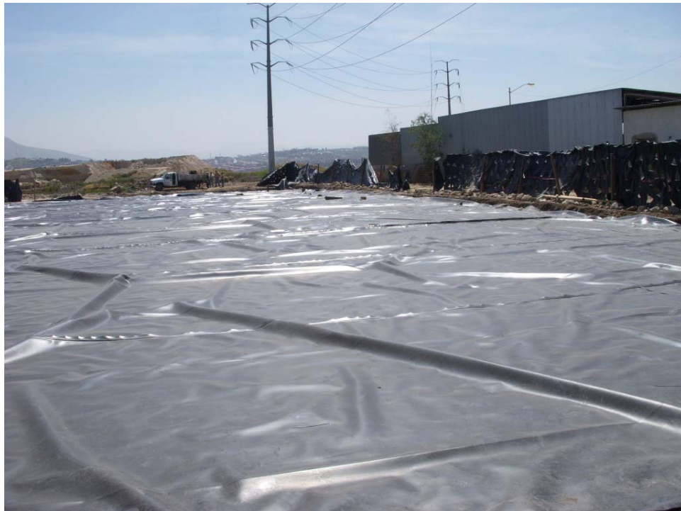
Figura 10. Vista de la geomembrana soldada en el suroeste de la celda
