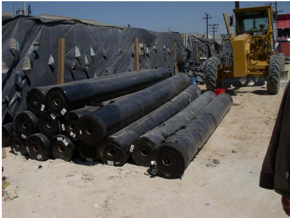
Figura12. Rollos de material geotextil para colocar sobre la geomembrana.
