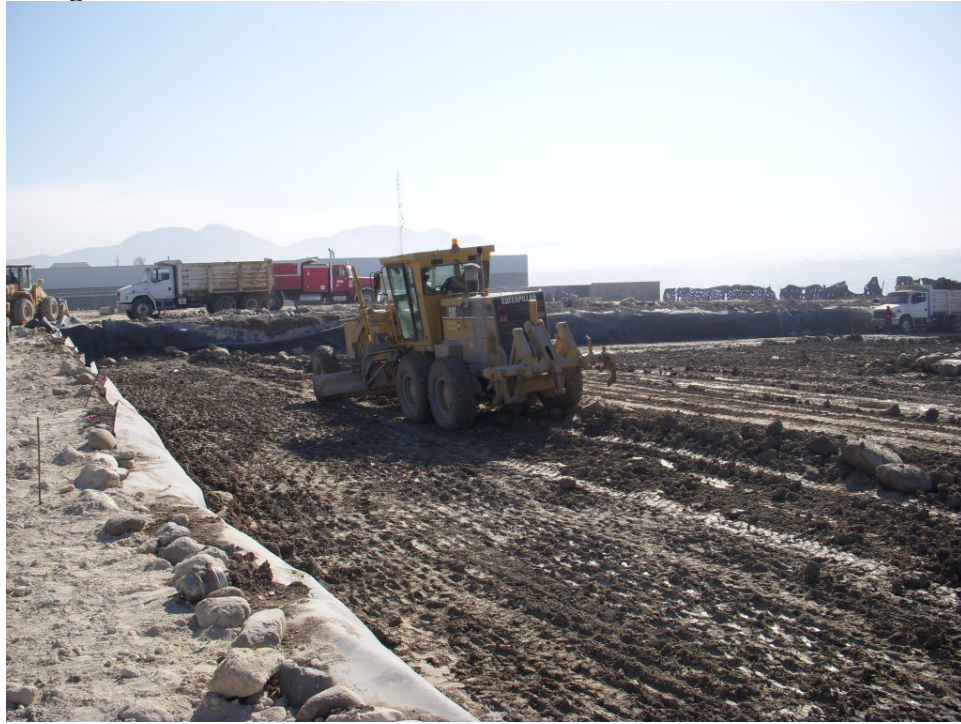
Figura 1. Estabilización dentro de la celda.
