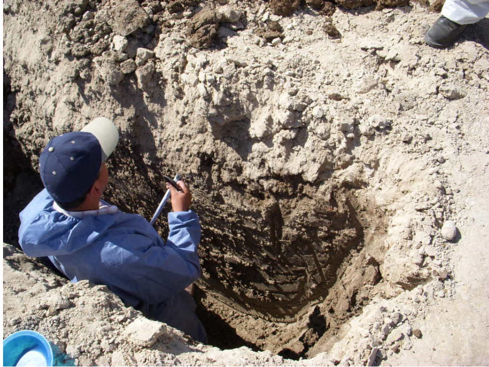
Figura 7. Limpieza de las paredes para tomar muestras.
