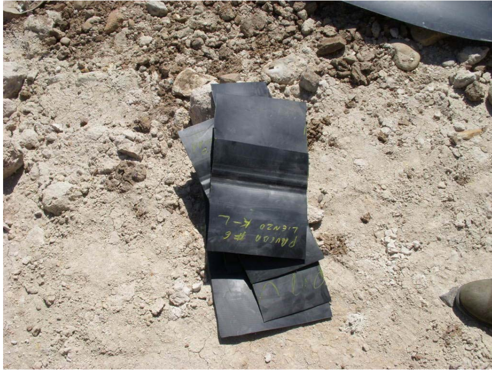
Figura 11. Muestras de pruebas destructivas de soldadura de la geomembrana.
