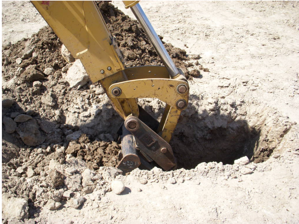
Figura 6. Escarbando hasta los 1.5mts.
